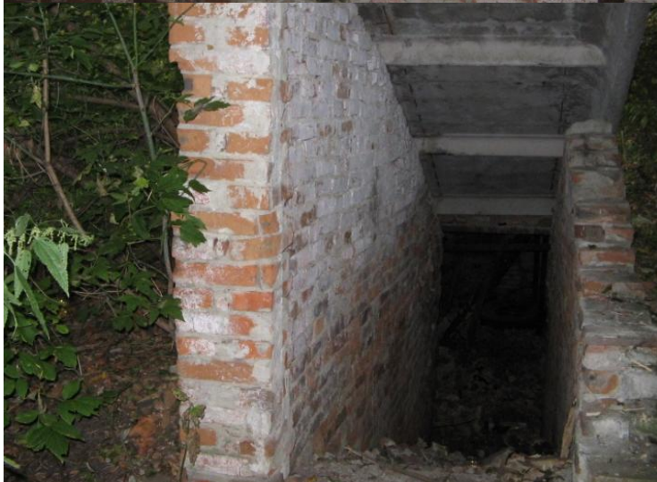
Фрагменты подвала на усадьбе А. С. Балабанова
