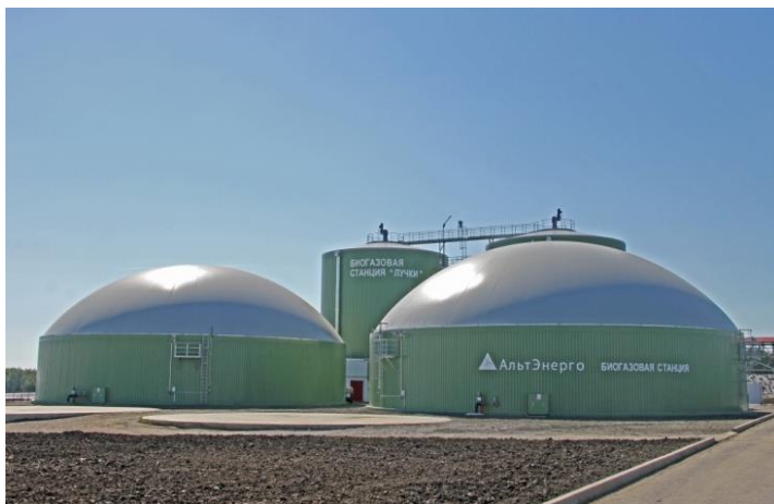
Рис. 4.14. Биогазовая станция «Лучки»
